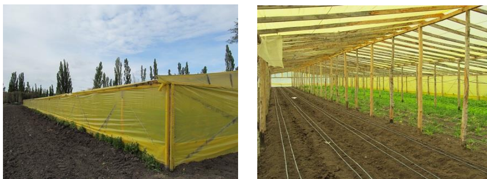
Figura 3 - Vista lateral e interna de invernáculos tipo “capilla” de madera. Fotos de los autores.
