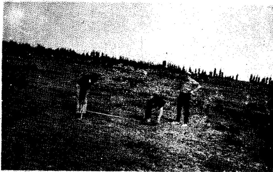
Perforando con barreno de 10 cm. de diámetro para colocación de freáticos.
